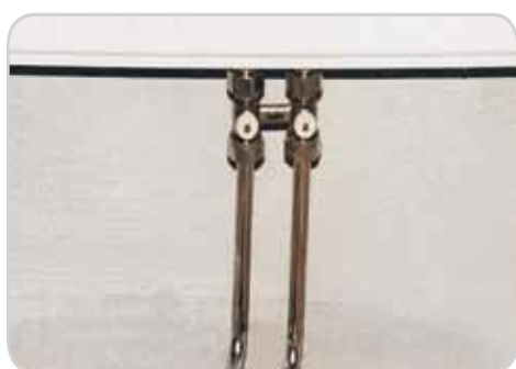
Összeszerelés radiátor bekötő könyök idomokkal
