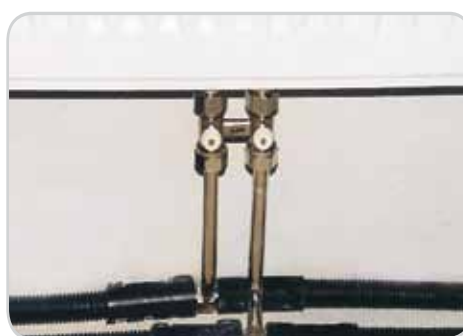
Összeszerelés radiátor bekötő T-idomokkal
